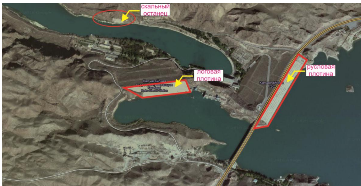
Рисунок 1 – Космический снимок гидротехнических сооружений Капчагайской ГЭС
