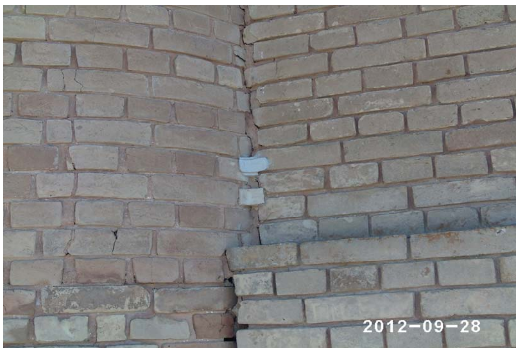
Рисунок 4 – Трещины в стенах мавзолея Арыстанбаб
